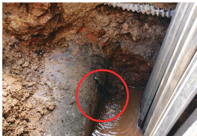
▲ 実際に発見した漏水箇所 (口径1000mm)
