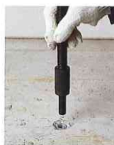
カップリングにめねじ用の ボルトをセット。
