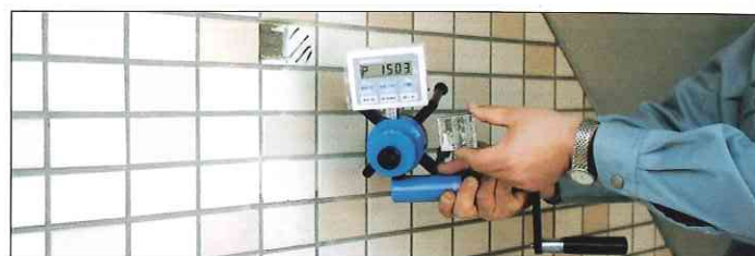
(外装タイル接着強度測定)
