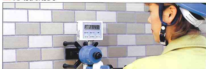
(外装タイル接着強度測定)
