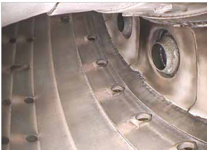
ガスタービン燃焼管
