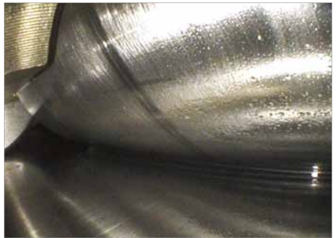
風力発電ギアボックス
