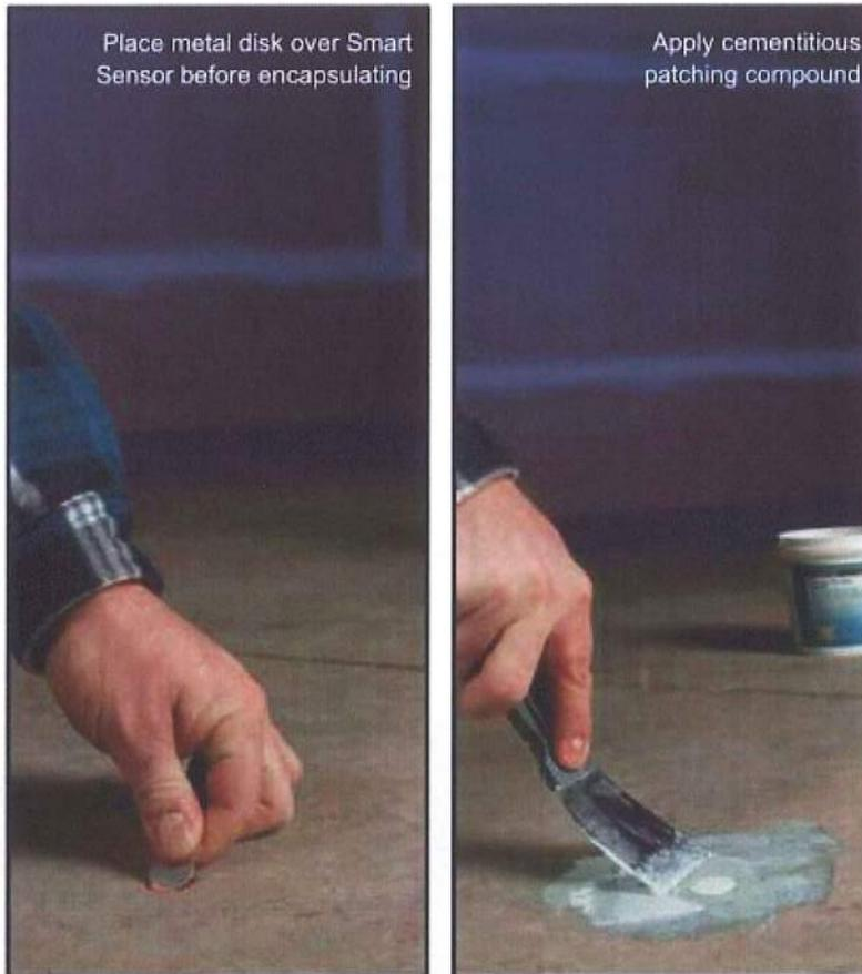
将来的には読取は不要になります。(例えば床のカバーリングやコーティングの準備が出来ているとき)ステンレス製の金属円盤をスマートセンサーの上におき、床材メーカーの取り付け指示書に互換性のある補修材でコーティングしてください。
