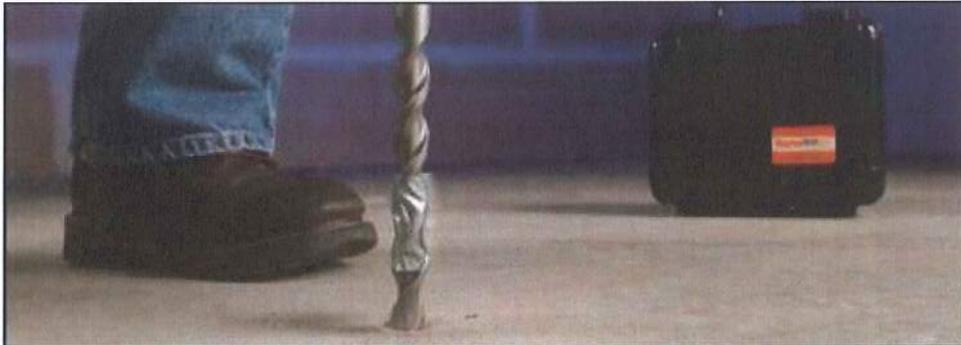
正しい穴の深さと径は ASTM F2170 の規格に準拠する上で重要です。(本書の最後の ASTM F2170 最良の測定 を参照) 同様に、スマートセンサーを容易に据付る為に、均一で丸い穴を開けることが重要です。ロータリーハンマードリルと3/4"石工ビットでコンクリート部材に必要な深さまで穴を開けます。ASTM F2170 規格にあるようにコンクリート部材の厚さの 40%に等しい深さまで穴をあけて一方から乾燥させます。或いは部材厚さの 20%に等しい付近まで開け、二方向から乾燥させます。適切なコンクリート湿度計の据付ではドリルをテストする表面に対して垂直(90°)であることを確認してください。
