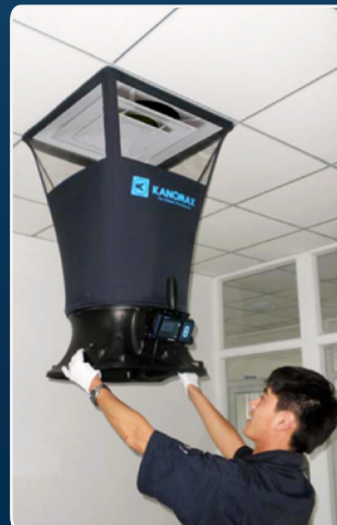
空調機器の点検・調整に
