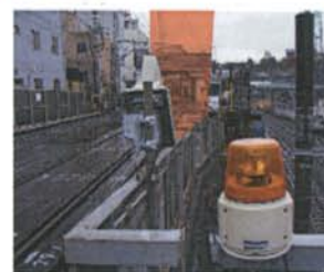
鉄道工事現場
