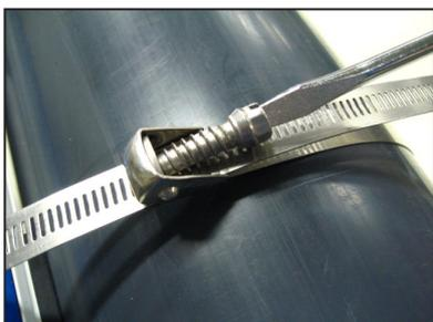
④ 張り具合を確認して締め具合を調整します。
