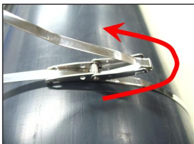
④ ベルトを折込みながら固定金具を倒します。
