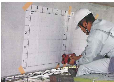
使用例2：橋梁上部工探査に (ブロックスキャンによる鉄筋かぶり厚の確認)
