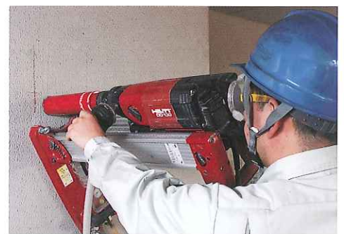
使用例3：穿孔前の鉄筋確認に (クイックスキャンによる鉄筋位置とかぶり厚の確認)
