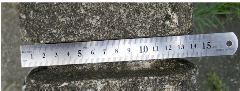
図 6-1 壁の厚み確認
