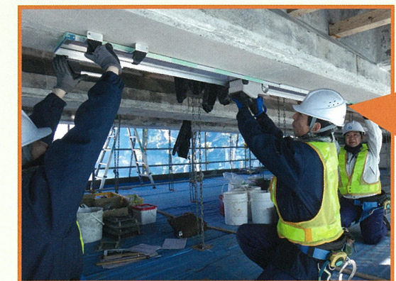
② PCT桁における磁束密度測定状況 (磁気計測ユニットを用いて)
