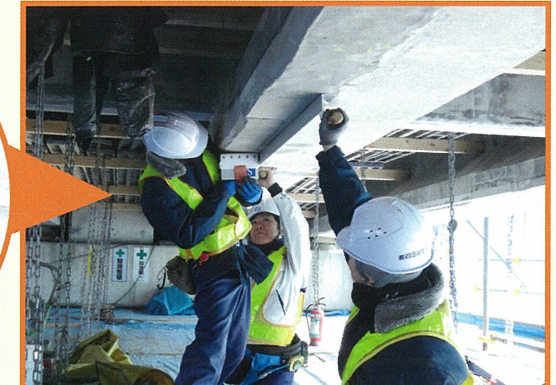
① PCT桁における着磁状況 (磁石ユニットを用いて)
