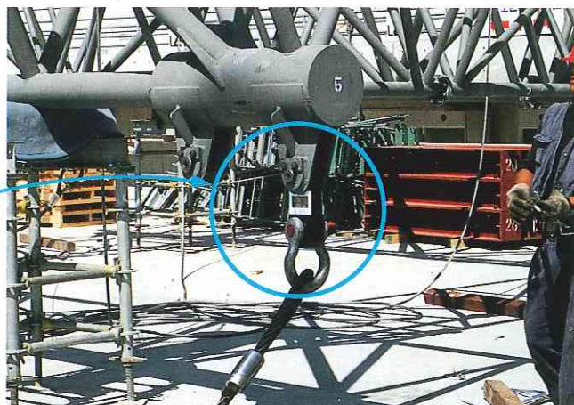
—— トラス構造屋根のバランス確認 ——
