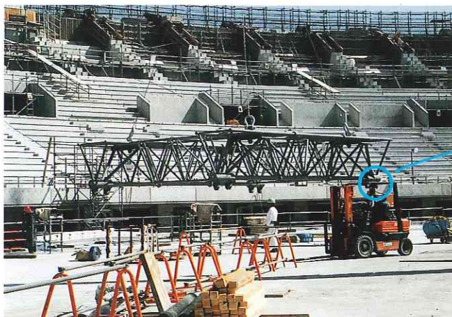
—— トラス構造屋根のバランス確認 ——
