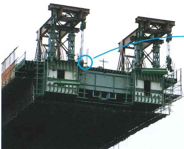
—— 高架橋作業, 張力荷重の測定 ——
