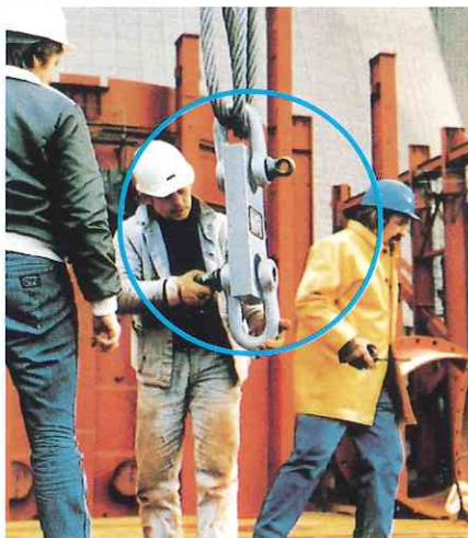
—— クレーン吊下荷重確認 ——
