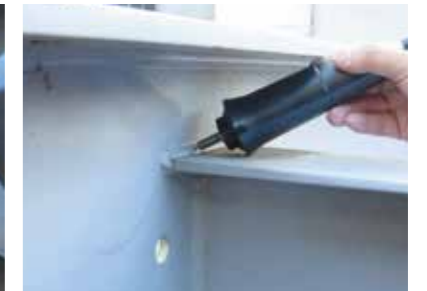
溶接部の溶接強度測定 (引張強度の確認)
